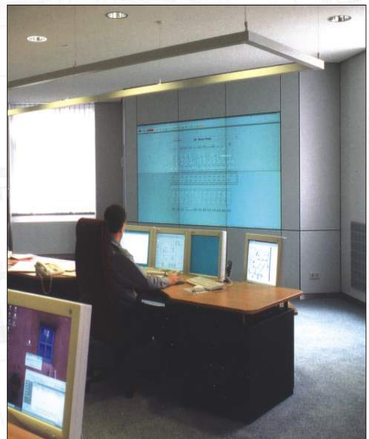
Bedienplatz in einer Querverbundwarte
